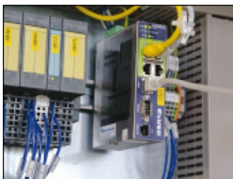
Die Fernwartungsrouter eWON von Wachendorff können für verschiedene Kommunikationsmedien von DSL bis HSDPA genutzt werden – je nach den Gegebenheiten beim Kunden.
